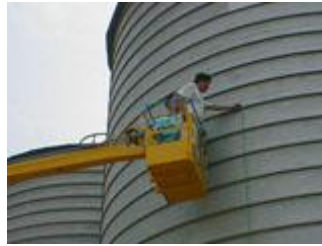
20、檢測單位在糧倉噴塗前後佈置和檢查測試點
