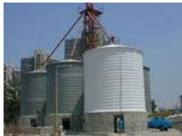
23、這是噴塗太空絕熱瓷層後糧倉外景和溫度曲線圖與測試報告，試驗倉表面噴塗 0.3~0.4mm 的太空絕熱瓷層與相鄰的對比倉比較：倉頂溫度最大下降 21.6°C，並可防護環境水汽對倉體外圍護的影響、阻礙水汽冷凝現象的產生。
