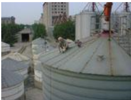
7、進行必要的除鏽處理
